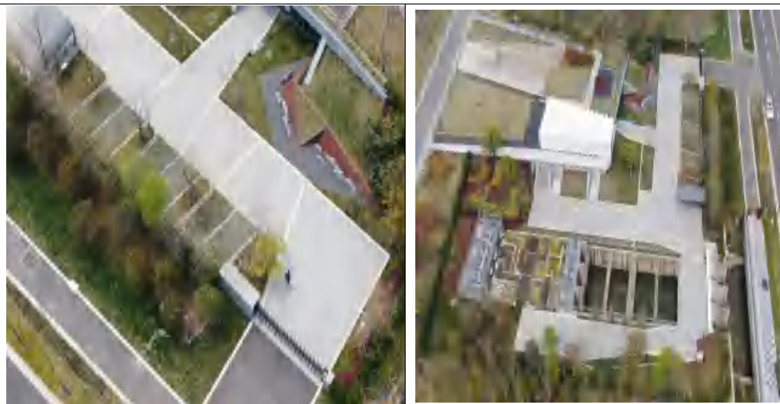
透水铺装及园林绿化照片（远景） 2022.8.15
