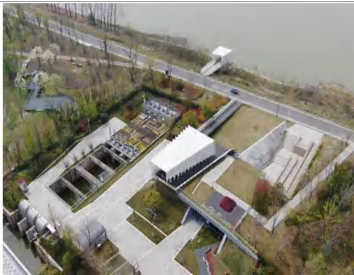
项目全景照片 2022.8.15
