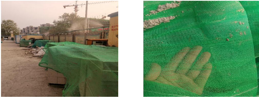
(c) 临时苫盖（拍摄时间为 2020 年 4 月）
