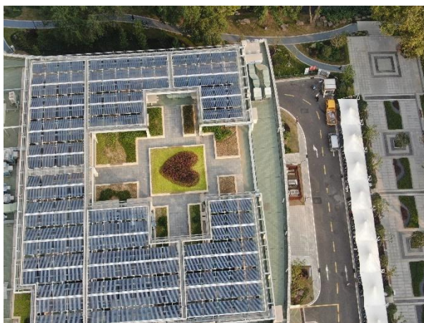
(b) 屋顶绿化（拍摄时间 2021 年 10 月）
