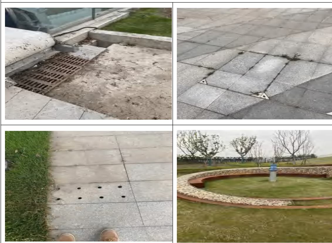
雨排管网照片 2022.6.15
