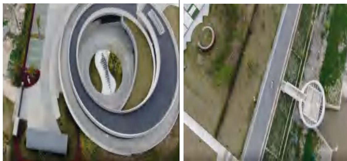
透水铺装及园林绿化照片（远景）2022.6.15
