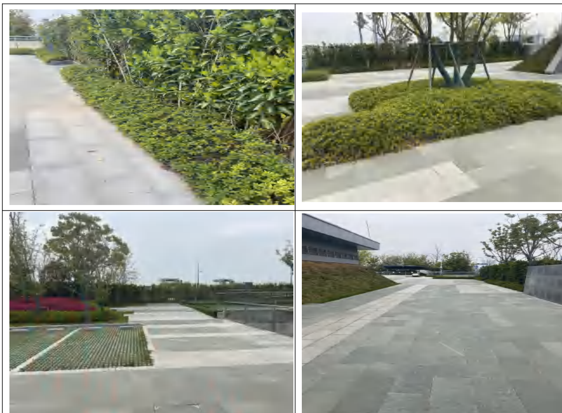
透水铺装及园林绿化照片（近景）2022.8.15
