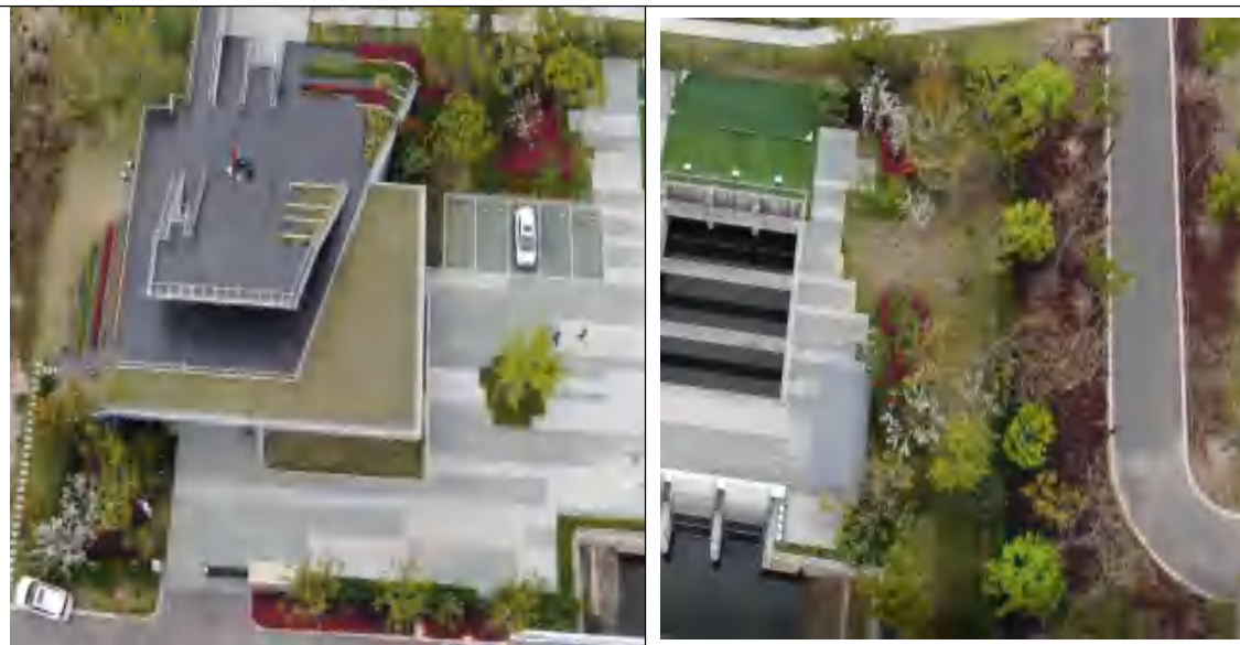
透水铺装及园林绿化照片（远景）2022.8.15
