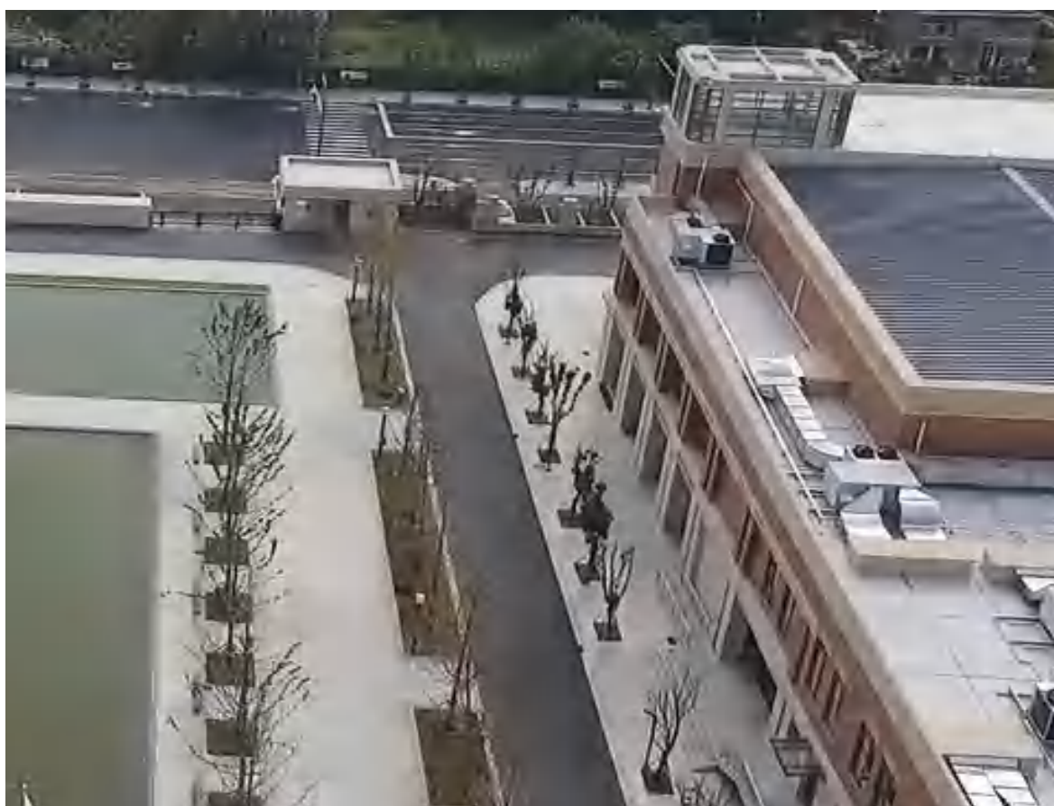
道路及建筑周边绿化（2019.10.16）
