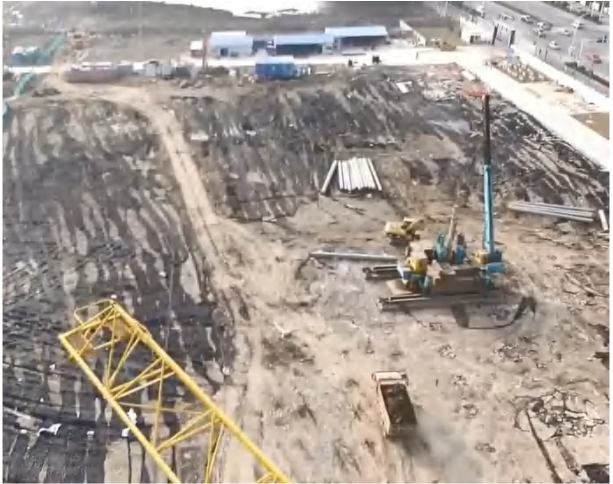
项目现场苦盖 (2017.2.27)
