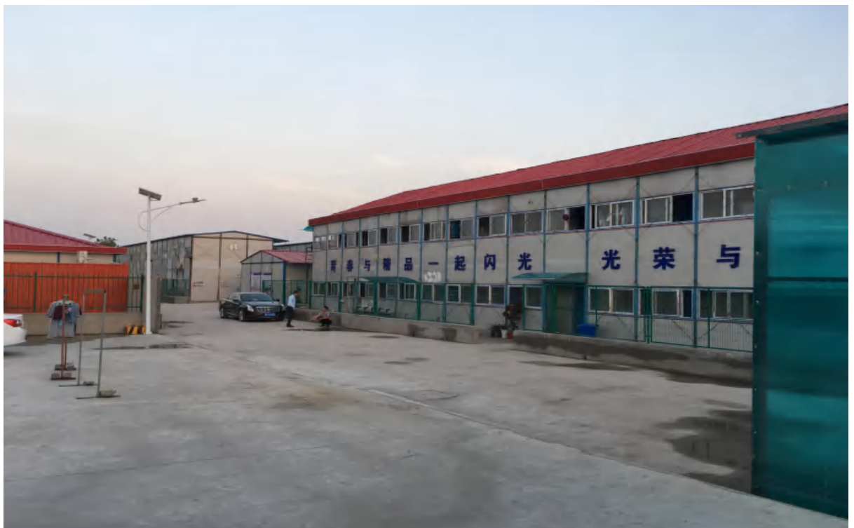
施工生产生活区 (2017.5.12)
