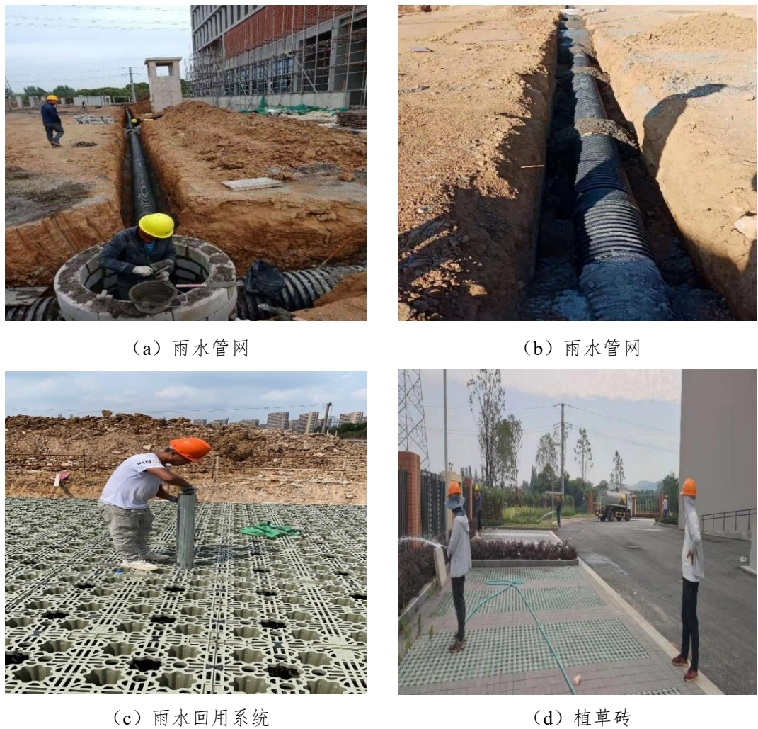
图 3.4-1 水土保持工程措施实施情况
