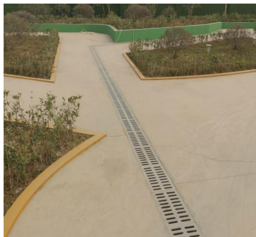
(b) 临时排水沟
