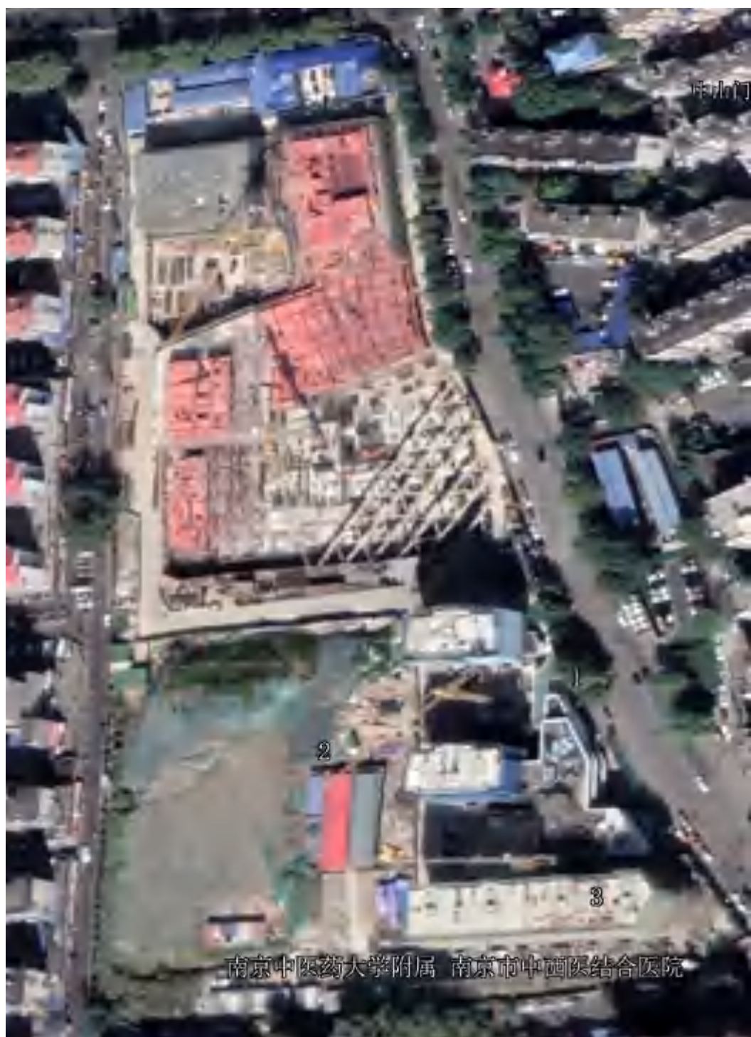
项目建设期遥感影像图（2020.11）
