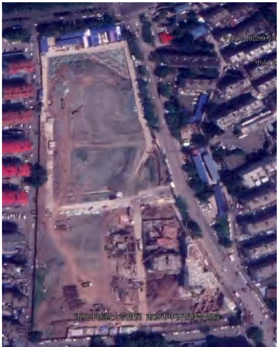
项目建设期遥感影像图（2020.1）
