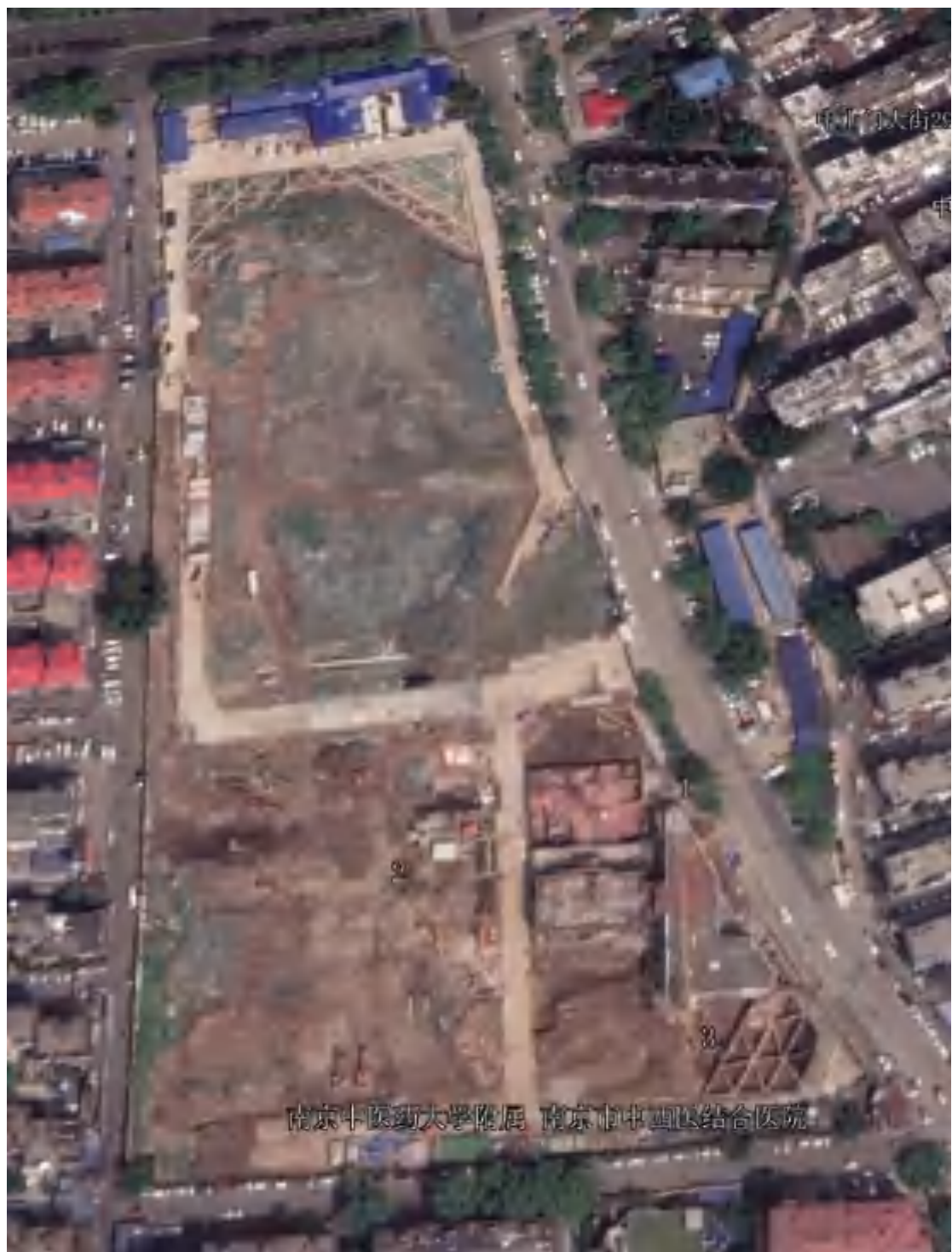
项目建设期遥感影像图（2020.4）
