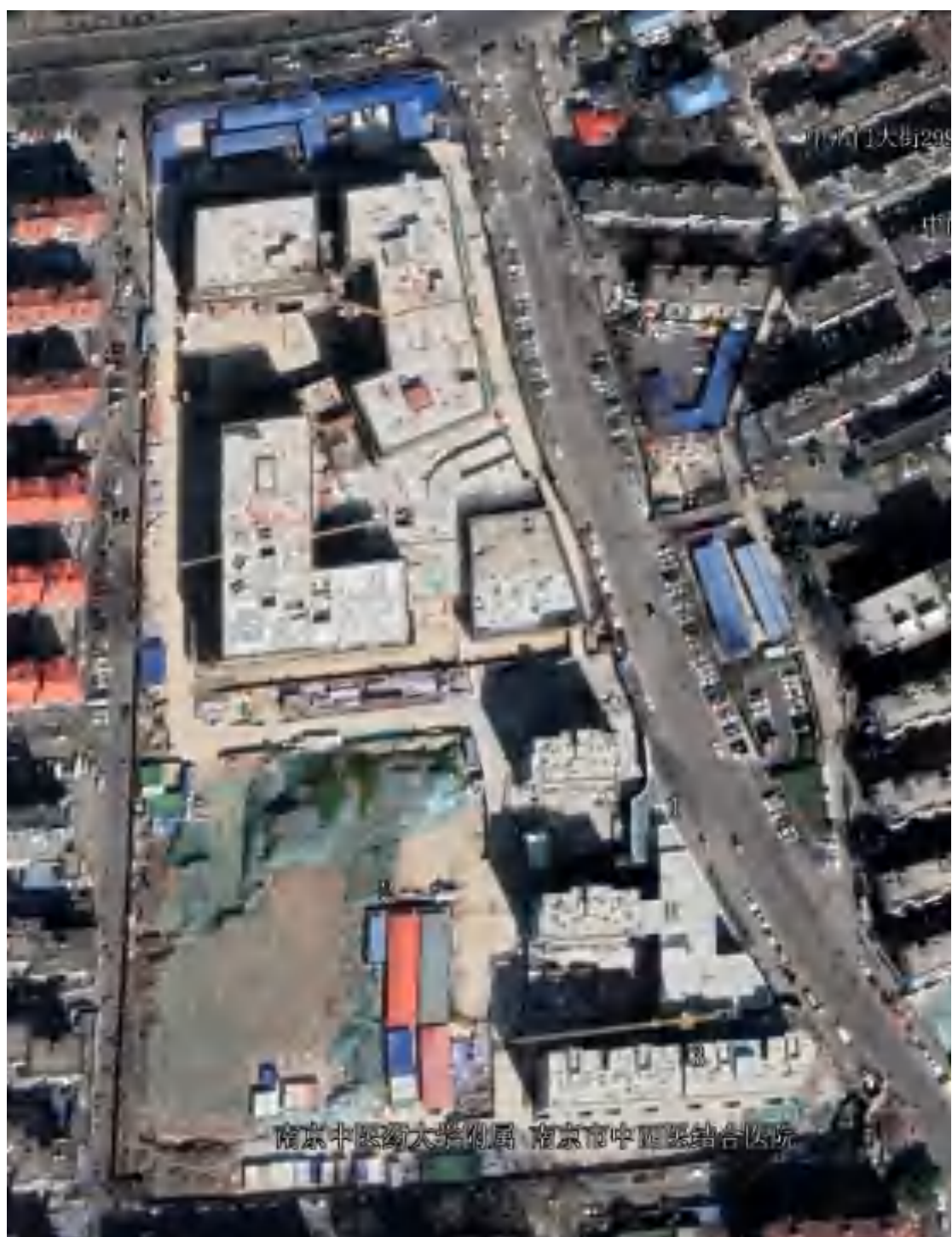
项目建设期遥感影像图（2021.2）
