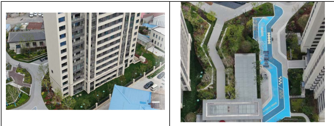
图 3.4-2 水土保持植物措施实施情况
