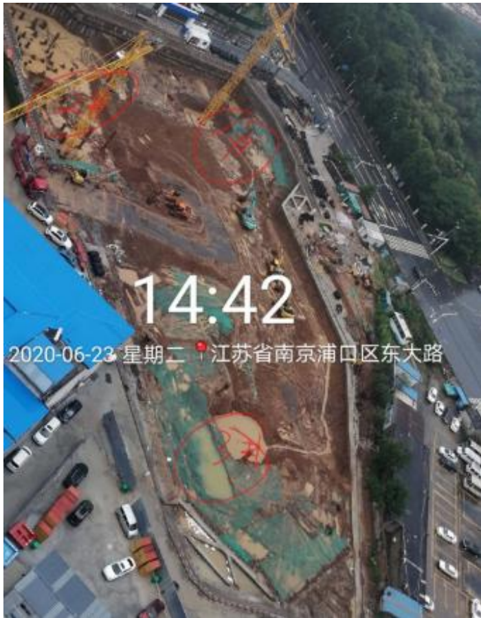
(b) 临时苫盖（拍摄时间：2020.6）
