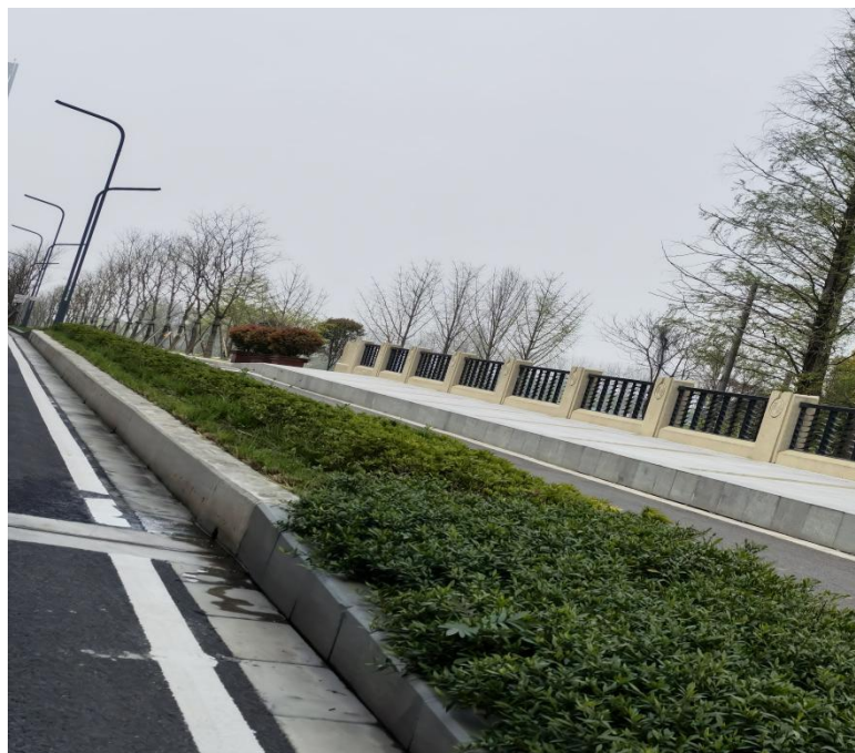
景观绿化、透水路面验收照片（2022.6）
