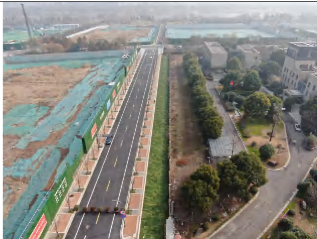
项目全景照片 2022.06.21
