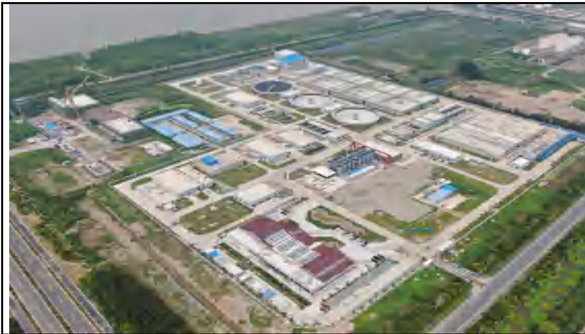
装饰整修施工阶段（2022年12月26日）
