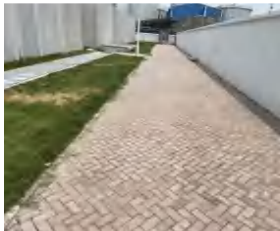
透水铺装（2022年12月20日）
