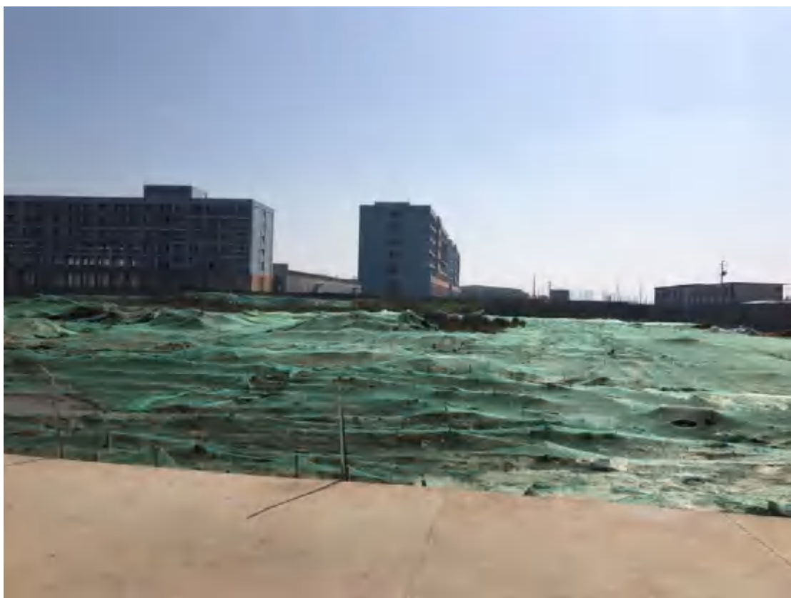
II 期工程临时苫盖（2021 年 5 月）
