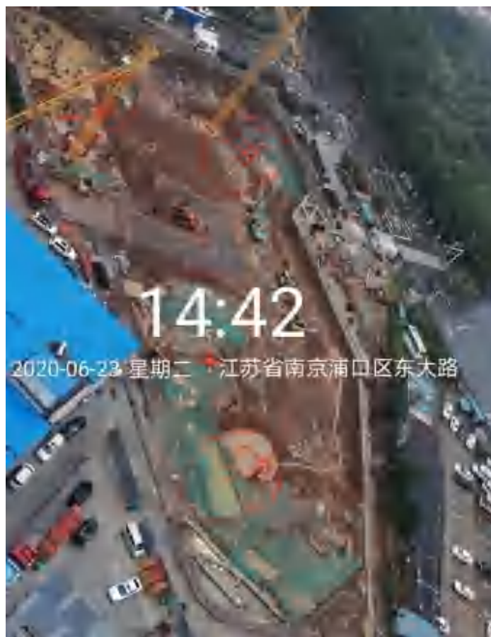
(b) 临时苫盖 (拍摄时间: 2020.6)
