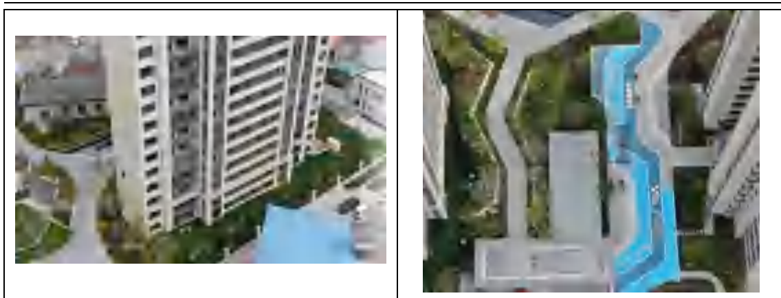
图 3.4-2 水土保持植物措施实施情况
